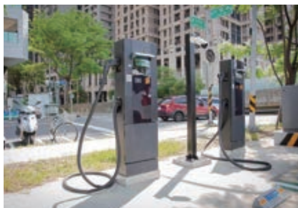
充電樁設置情形
