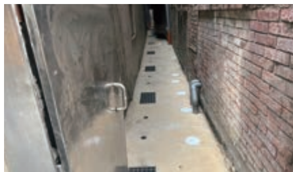
污水下水道建設工程
