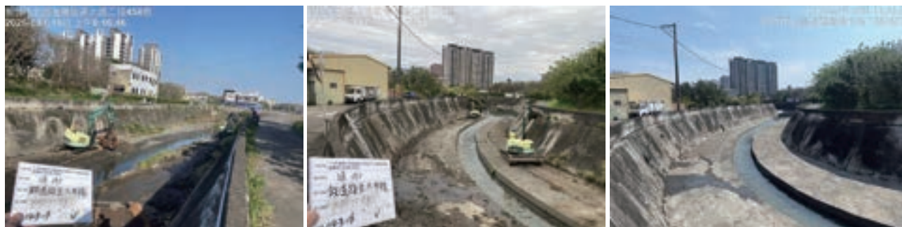
區域排水(東大排)清淤作業
